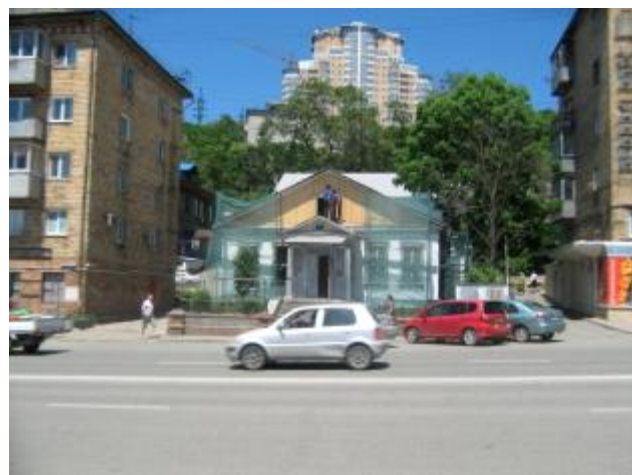
Дом-музей, ремонтные работы, июль 2011 г.
