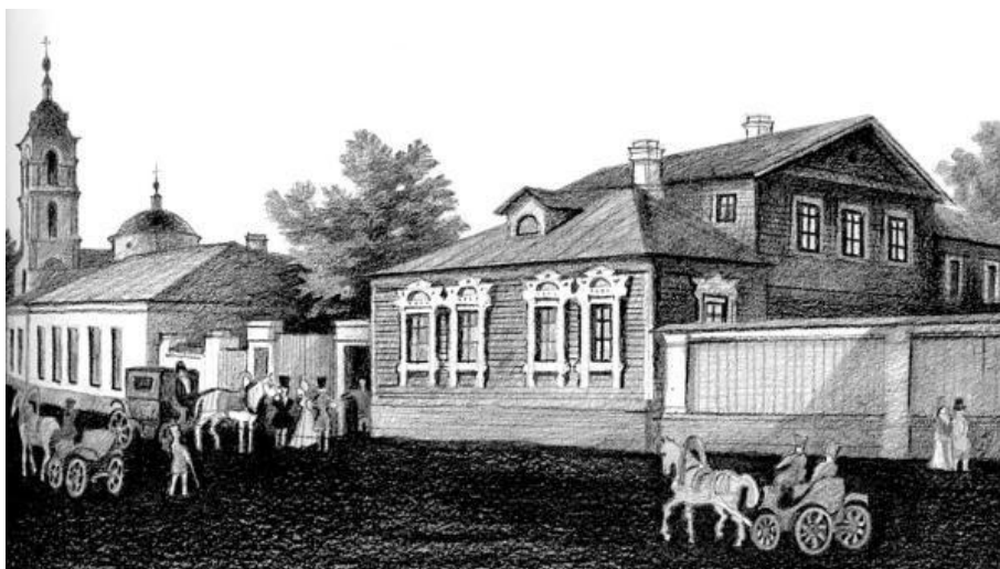
Дом Григорьевых в Москве на ул. Полянка, 12
