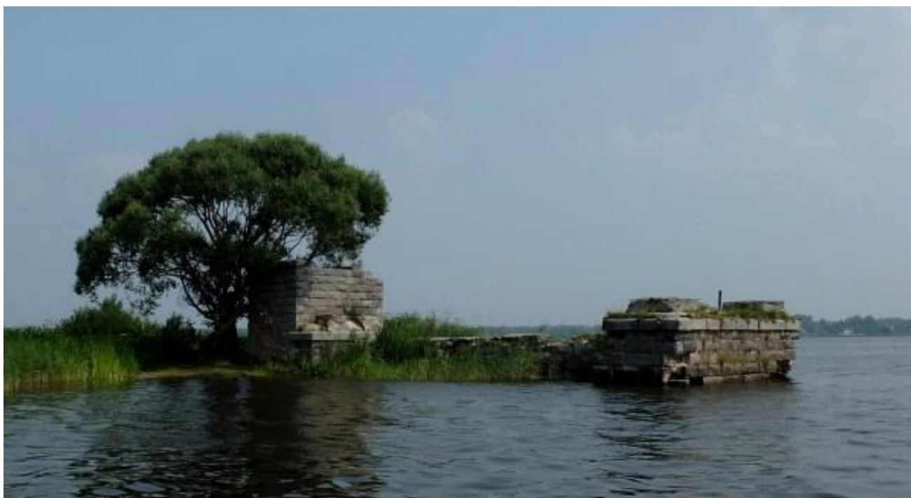
Опоры старого моста
